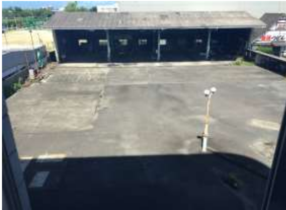
↑↑ 駐車場スペース(ビル裏)
