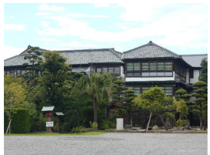
▲日奈久温泉街の木造建造物
