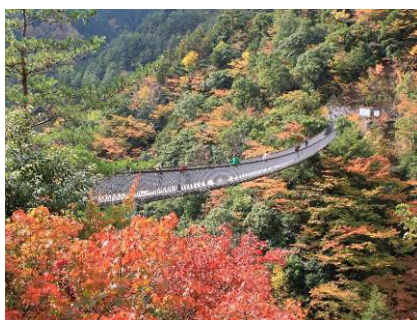
▲梅の木轟公園吊橋
