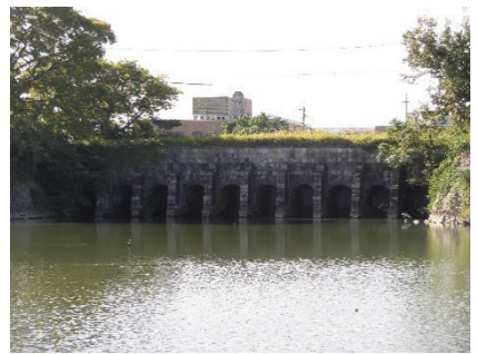
▲旧郡築新地甲号樋門
