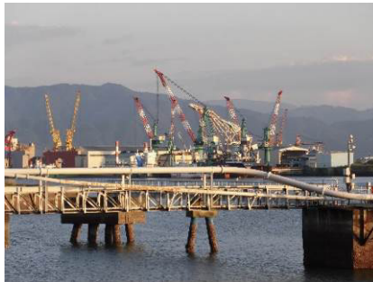
▲工場地のクレーン群
