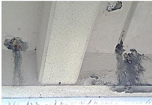
コンクリートのはがれ 鉄筋のさび
