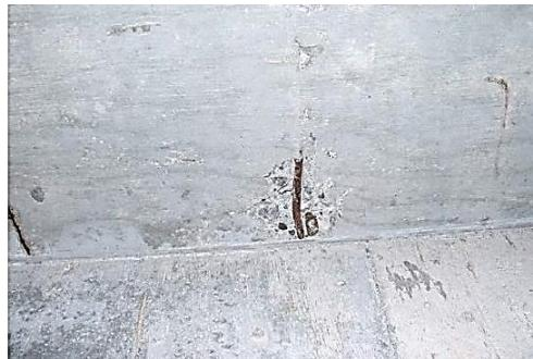
コンクリートのはがれ、鉄筋のさび
