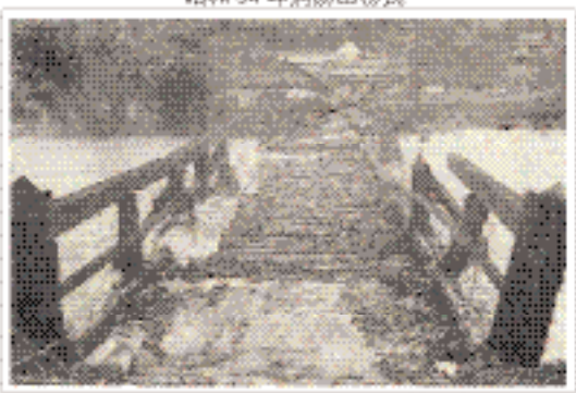
昭和47年集中豪雨により大村橋が崩壊
