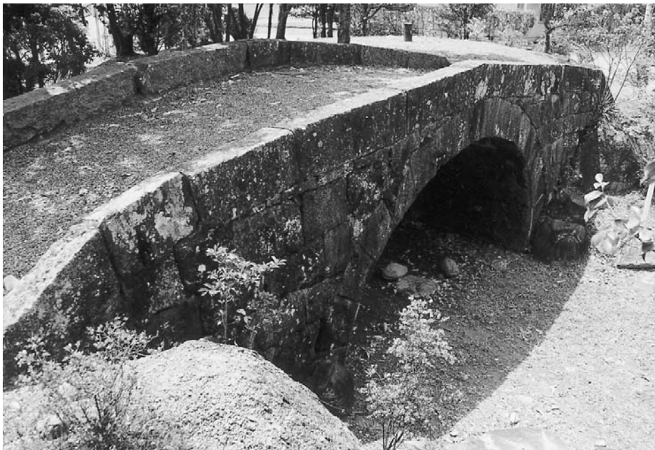
相良村役場の敷地内に移設された橋谷橋（石本豊吉作）
