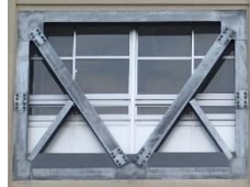
枠付き鉄骨 ブレース補強
