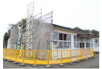
▲塗装と補修作業が行われた作業棟
