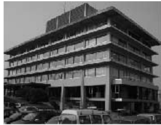
当分の間、新市の市役所となる八代市庁舎
