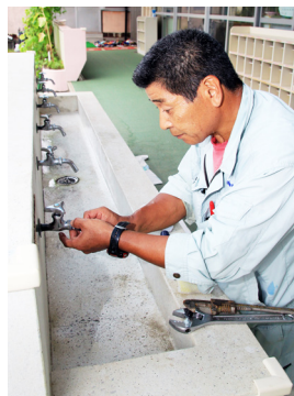
▲吐水パイプを取り外し、蛇口内部を点検
