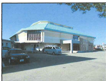
松高小学校（体育館外観）
