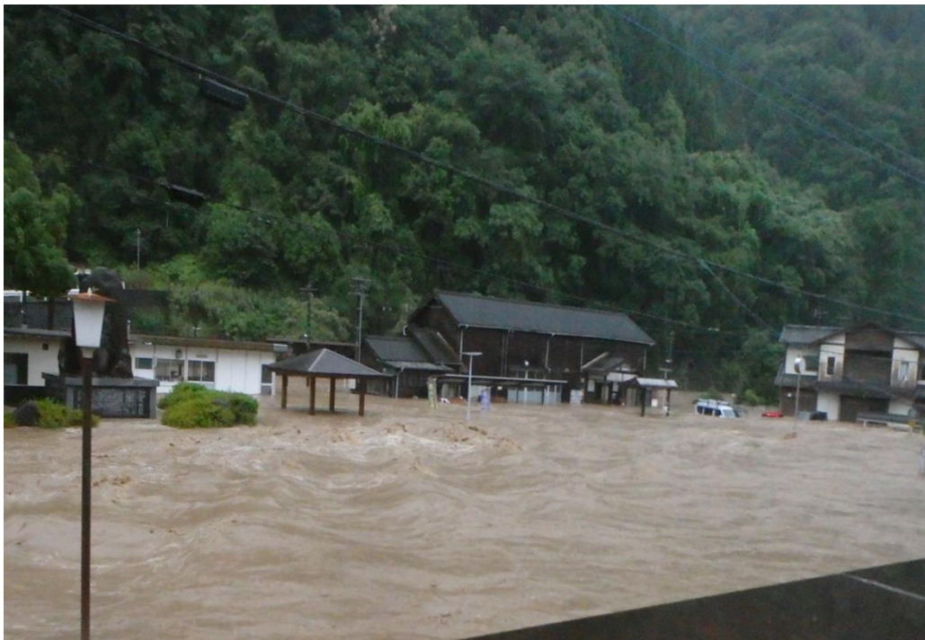
令和2年7月豪雨 JR 肥薩線坂本駅前
