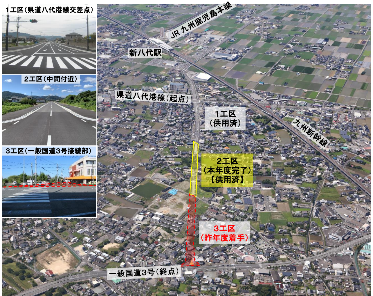
(都) 西片西宮線 全景 (令和4年6月撮影)
