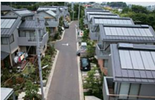
太陽熱利用設備
