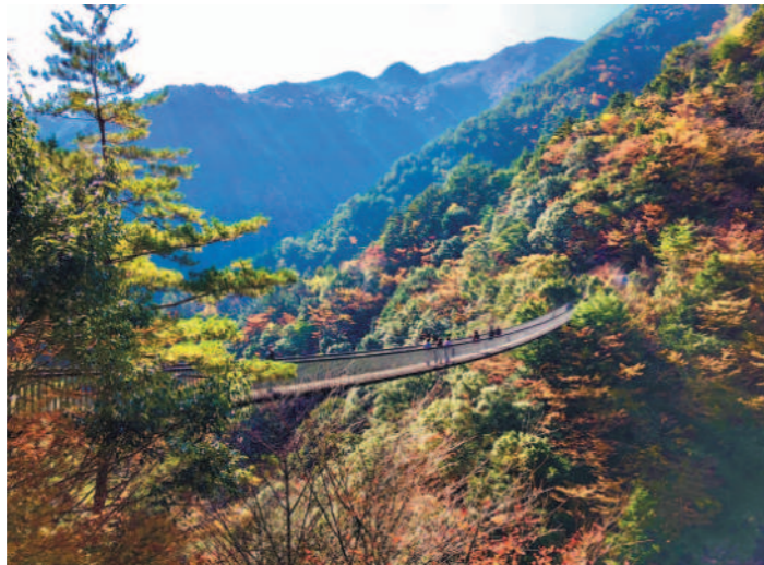
梅の木轟公園吊橋
