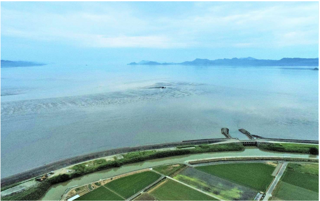
【金剛第一号樋門から八代海を望む】
