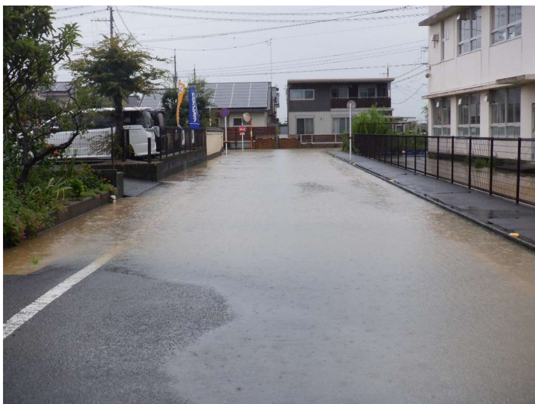
(令和3年8月13日 大雨時の千丁小学校横の道路冠水状況)
