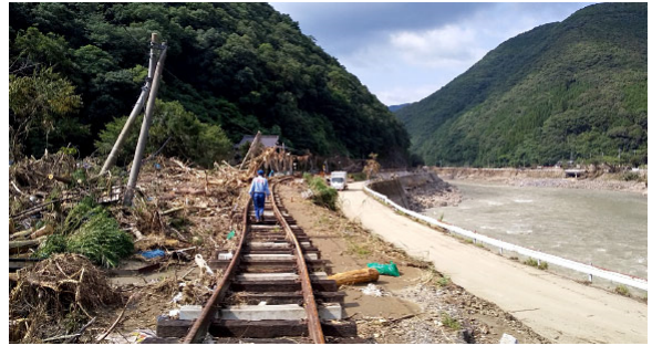
▲土石流等の被害(JR 肥薩線 吉尾地区)
