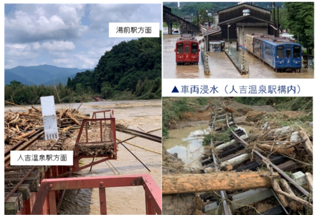
▲川村駅～肥後西村駅間 球磨川第4橋梁 (L=322m) 流失
