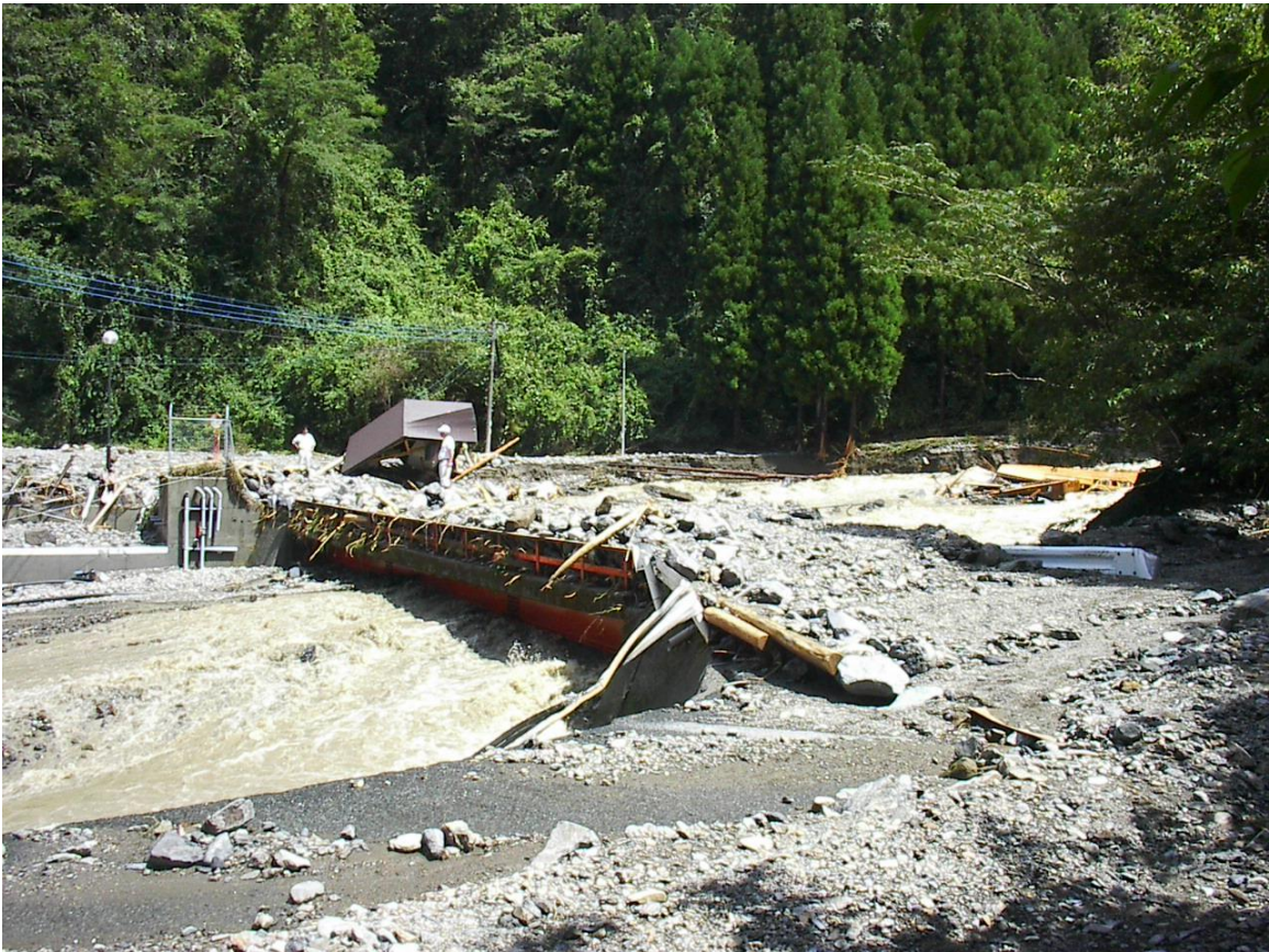
泉町 山ノ津谷川（平成17年 台風14号被災）
