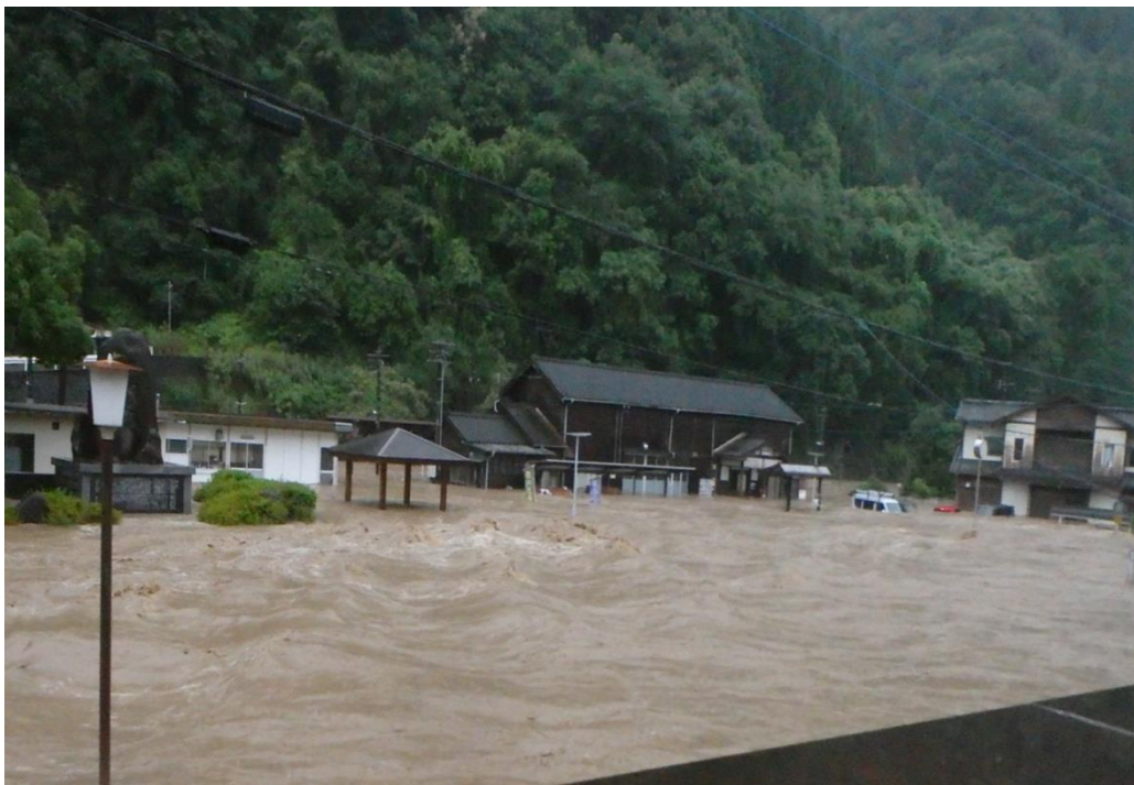
令和2年7月豪雨 JR 肥薩線坂本駅前
