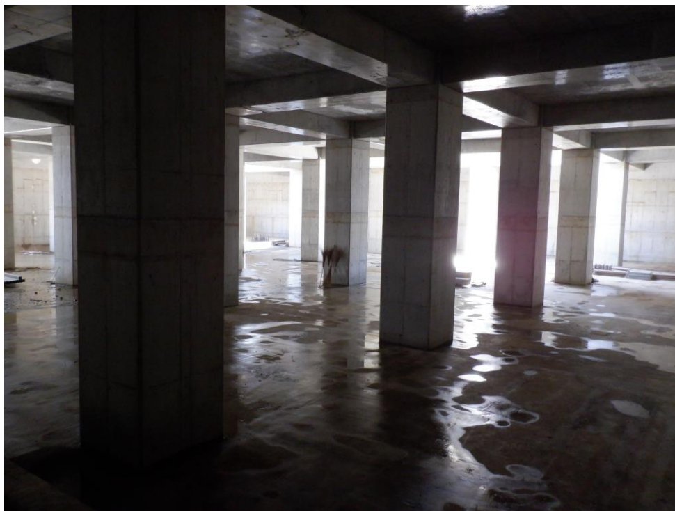
「防災・減災、国土強靱化のための3か年緊急対策」で実施した 北部中央雨水調整池整備工事の状況
