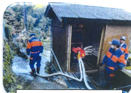
朴ノ木地区ポンプ点検
