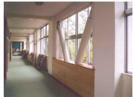
【鏡小校舎耐震補強工事】
