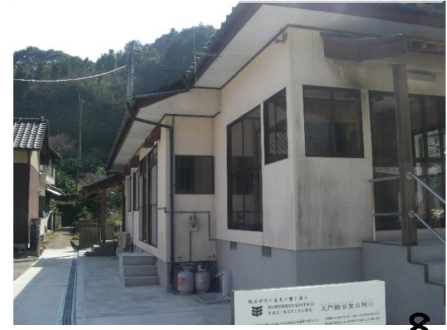
⑥宅地かさ上げ完了
