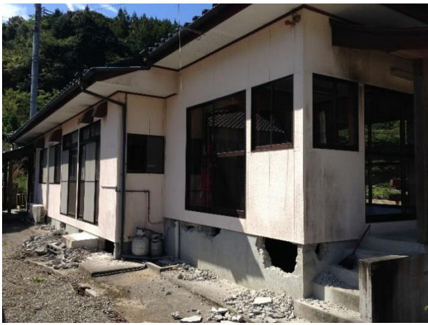
①基礎部分の縁切り
