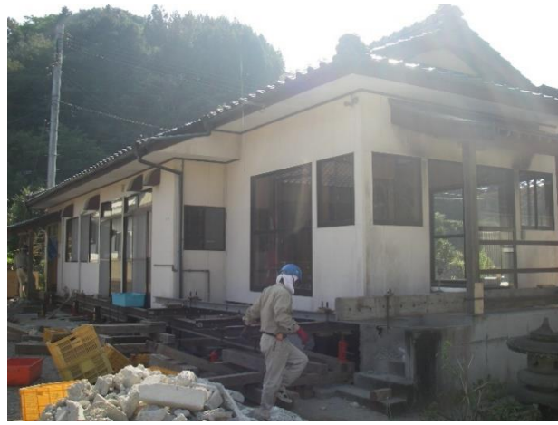
②ジャッキアップ
