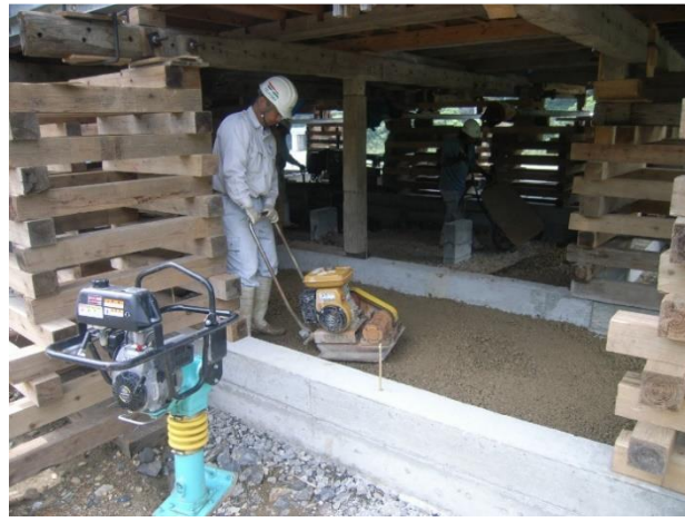
⑤盛土材の締固め
