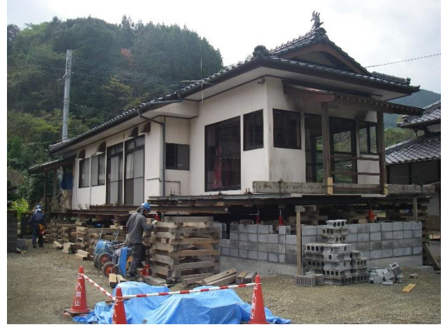
③枕木の設置
