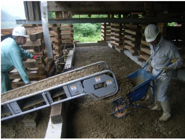
④盛土材の搬入
