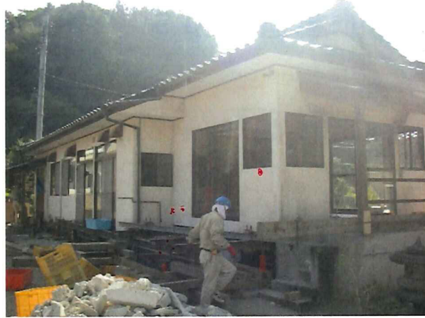
②ジャッキアップ
