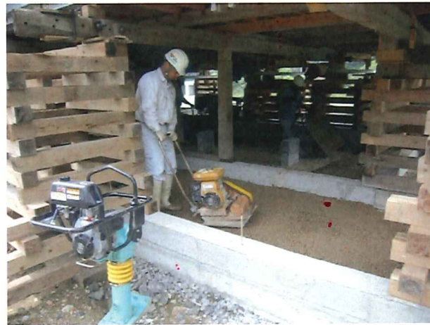
⑤盛土材の締固め
