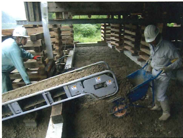
④盛土材の搬入
