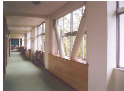
【鏡小校舎耐震補強工事】
