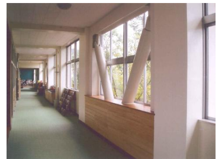
【鏡小校舎耐震補強工事】
