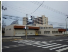
東側から見た外観
