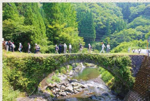
ろくろばし 鹿路橋
