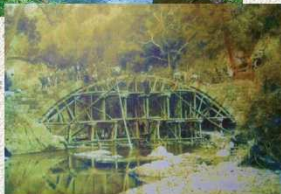
建設中の谷川橋
