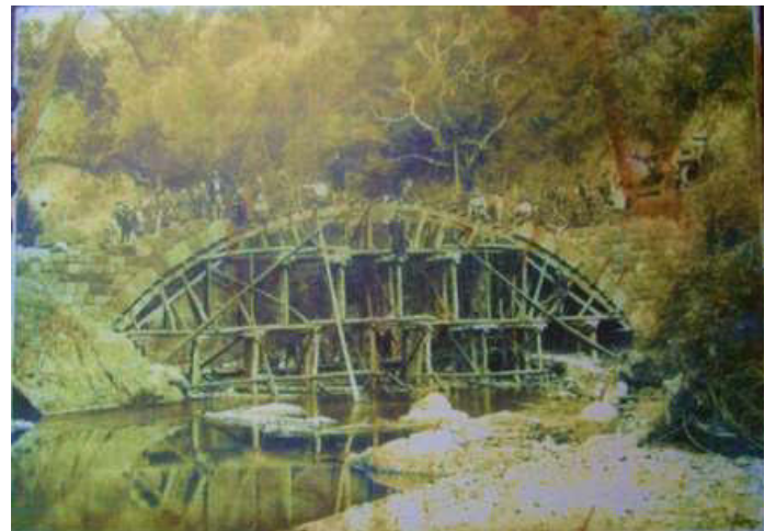
16. 谷川橋(架橋当時の写真)
