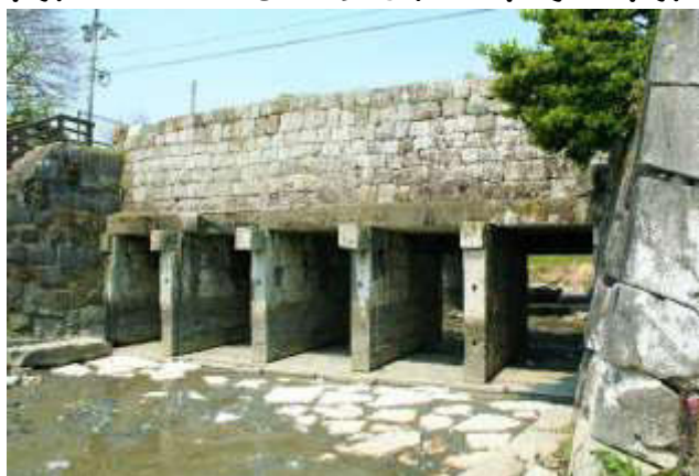
6. 大鞘樋門群(殻樋)
