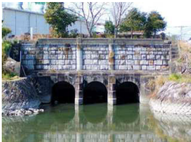
11. 郡築二番町樋門(正面)
