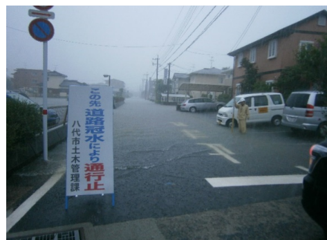
(八千把地区における道路冠水時の様子)
