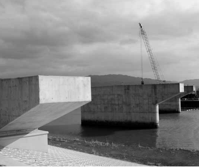
▲工事が進む南部幹線の橋脚
