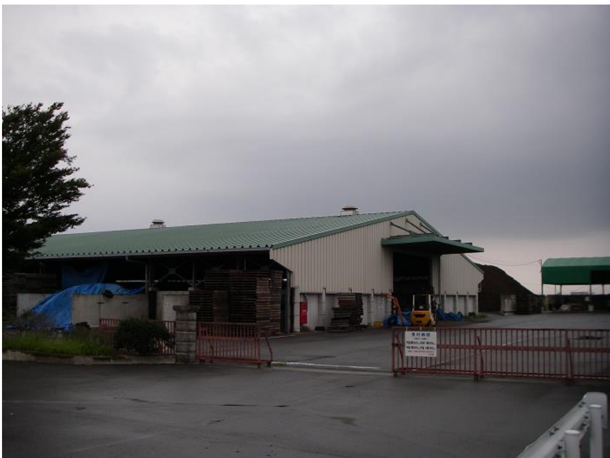
写真 II-2 樹木剪定くずリサイクル施設全景
