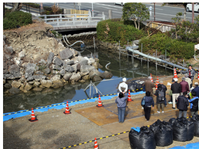
▲被災した廊下橋門跡石垣を見学する参加者
