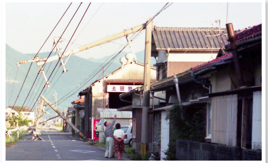
台風19号による電柱倒壊(古閑中町)平成23年撮影
