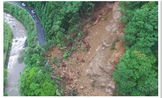
豪雨による土砂崩れ(坂本町)平成28年撮影
