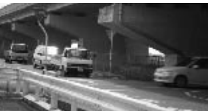
信号機の早期設置が望まれる西回り自動車道側道の交差点
