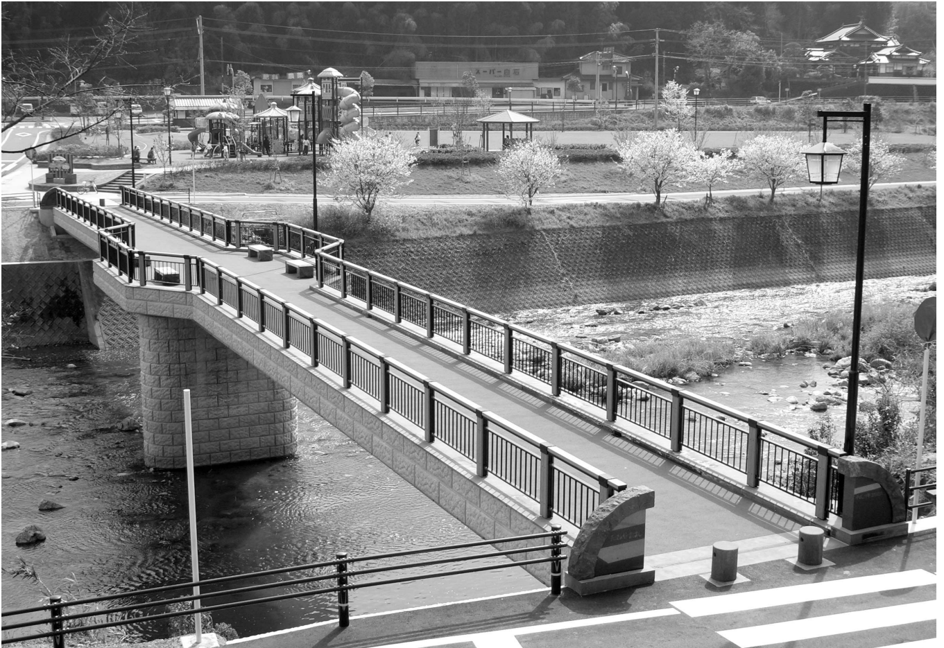
▲種山橋（東陽町）：森下地区歴史水辺公園整備事業として建設された歩行者専用橋 平成19年3月開通
