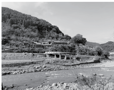
対岸から見た村平橋の改修状況
